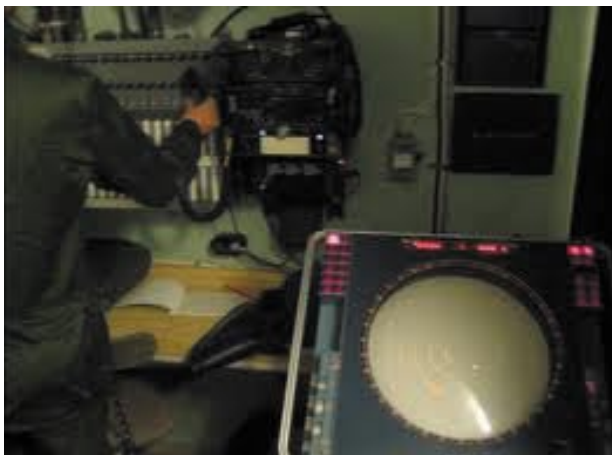
NSRR i maskinhuset.
