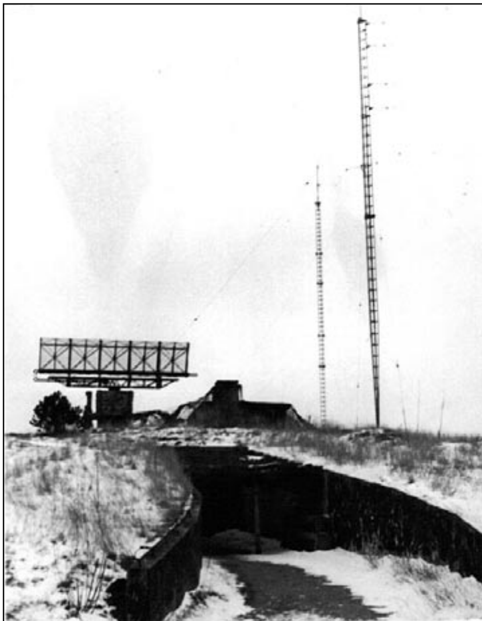
Ingången till radarstationen samt MDÖ:s vapen.
