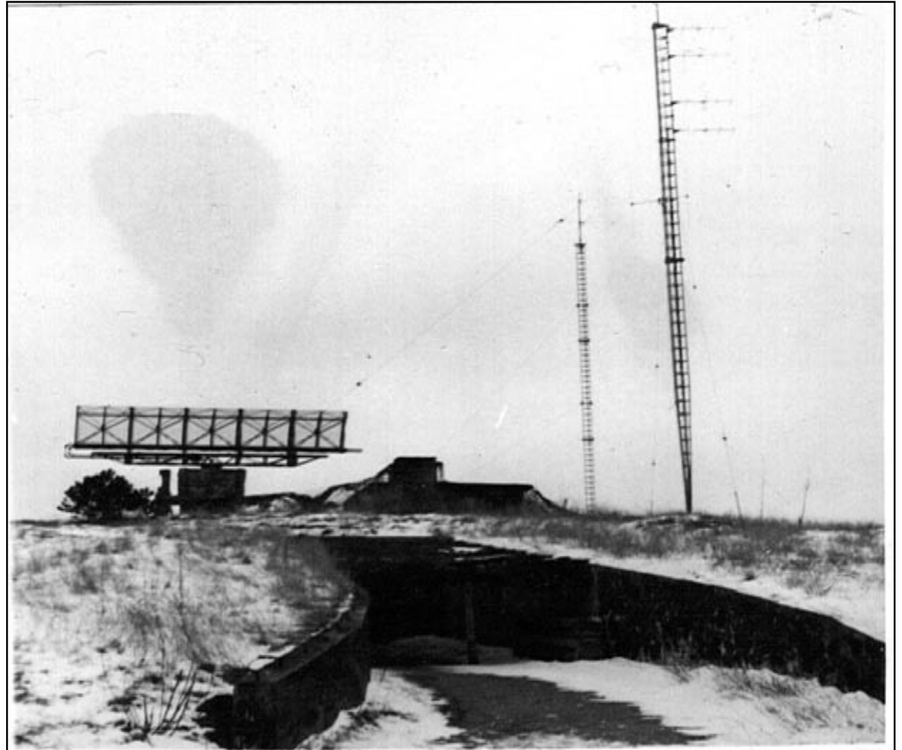
Ingången till radarbunkern och kommunikations-antennerna.
