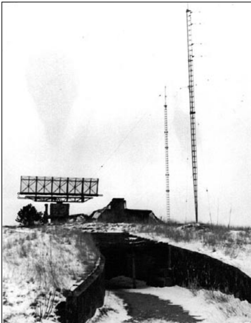
Ingången till radarstationen samt MDÖ:s vapen.
