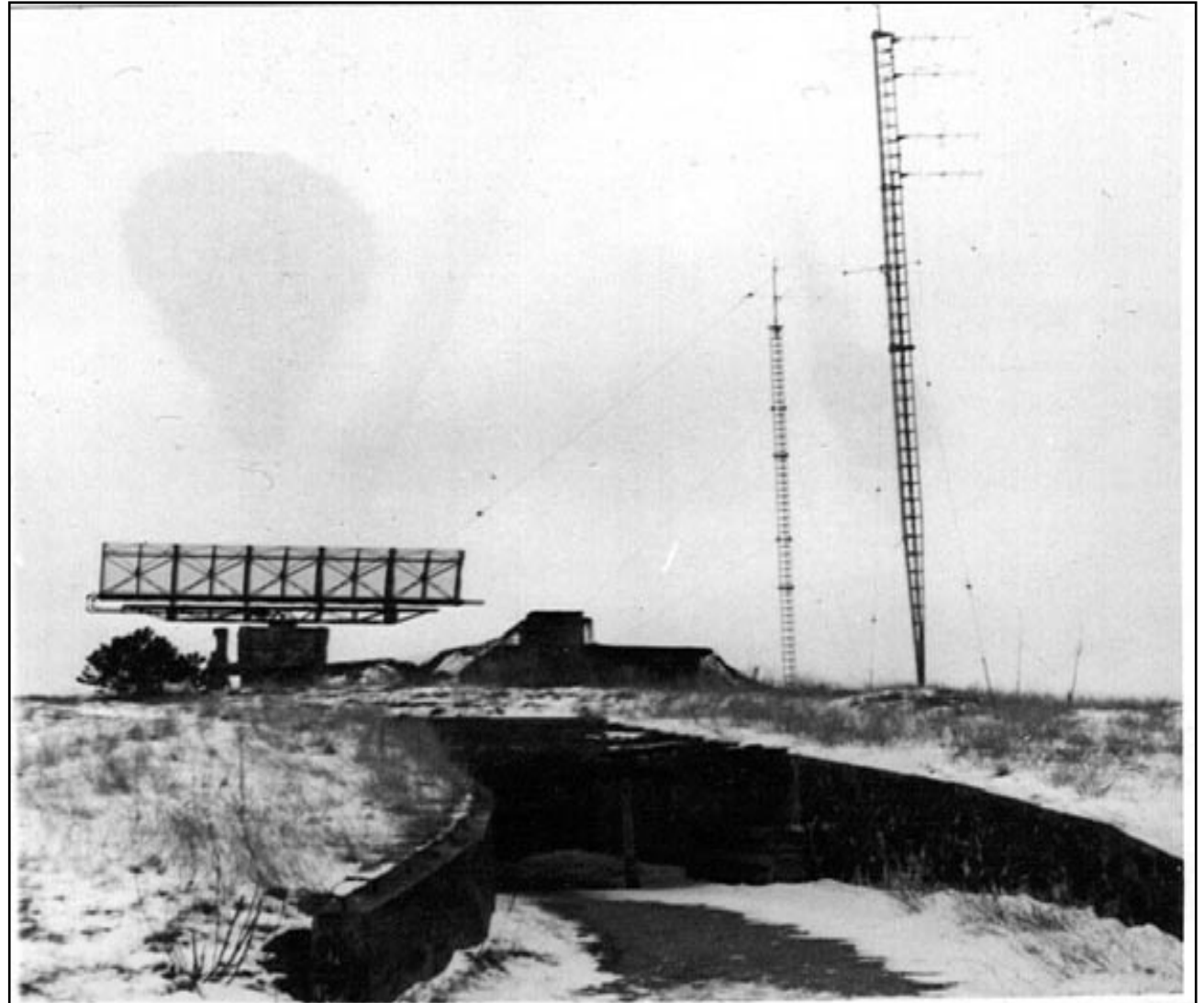
Ingången till radarbunkern och kommunikations-antennerna.
