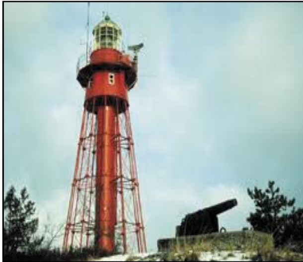
Närspaningsradar på fyren av typ PS 615 placerades uppe på balkongräcket på fyren.
